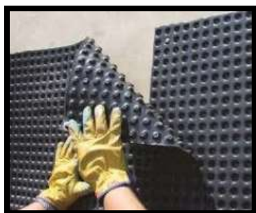
Traslape de la lámina
